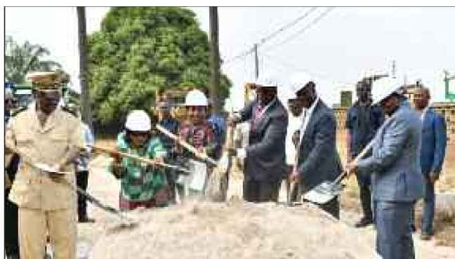
Les ministres Amedé, Goudou Raymonde et Bandama Maurice ont procédé aux lancements des travaux de la voirie de Toumodi et Taabo.
