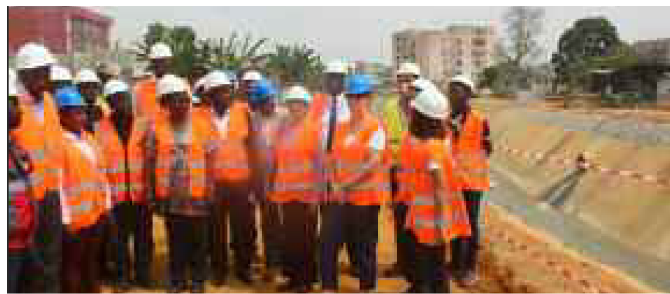
La vice-présidente de la Banque mondiale (3e de la droite vers la gauche) était sur le chantier pour se faire une idée de l'avancement des travaux
